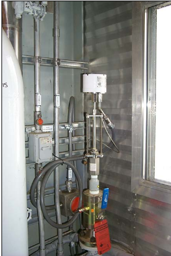
Transmisor Microcor y sonda retráctil en instalación de campo
