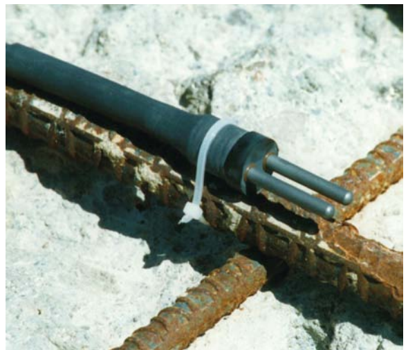
Sonda colocada sobre la barra de refuerzo Longitud del electrodo 1,25" (32 mm)
