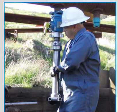
Utilisation sur le terrain de la vanne de service et de l'outil de rétraction
