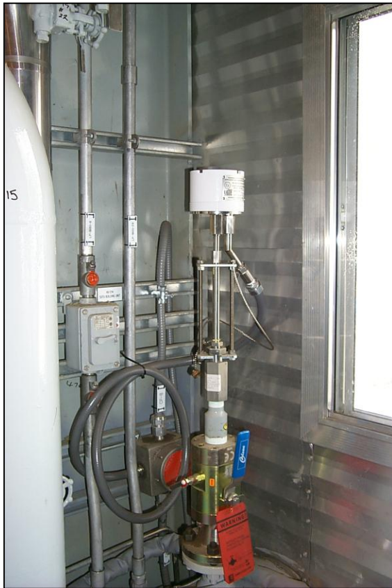
Установка передатчика и выдвигного зонда Microcor в полевых условиях
